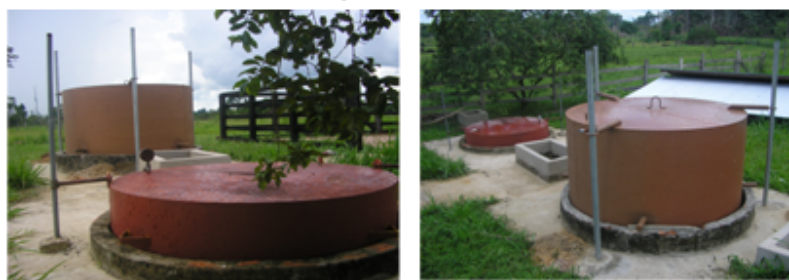
Gasômetro-1 e gasômetro-2
