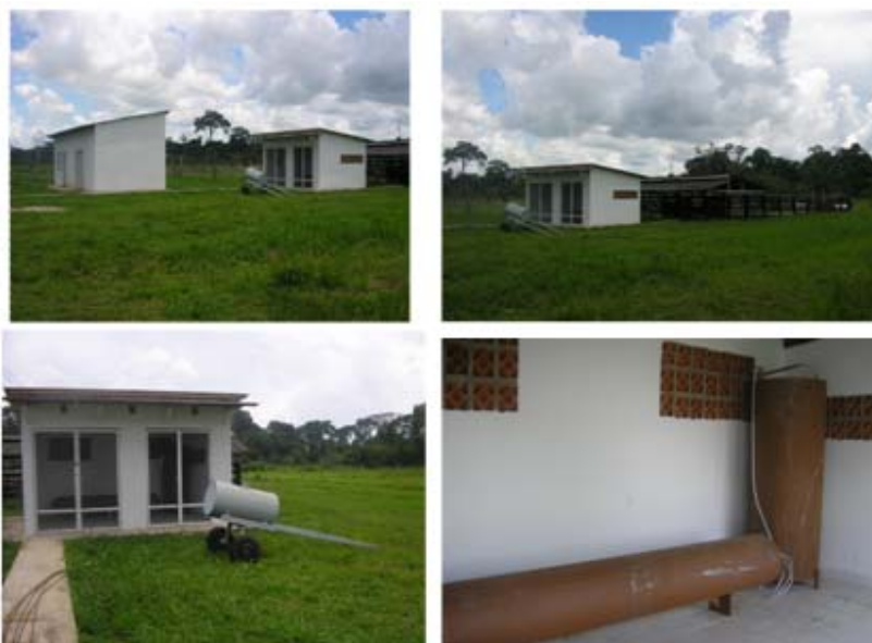
Figura 3. Instalações do laboratório e sistema de compressão do biogás, no Limoeiro.
